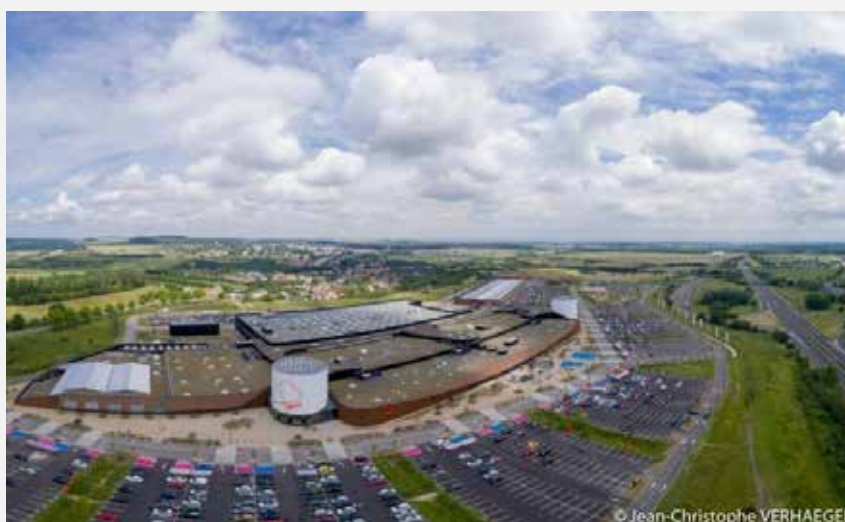
Figure 1 : Centre commercial B'EST à Farébersviller (Moselle)
